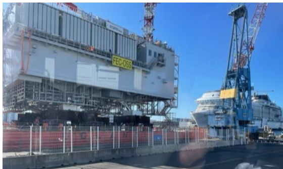
Vue sur un transformateur électrique maritime et sur un paquebot des chantiers navals de Saint-Nazaire
